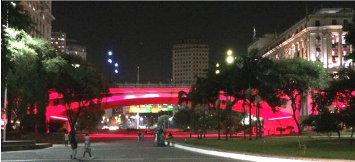
VIADUTO DO CHÁ 323 LED lamps installed
