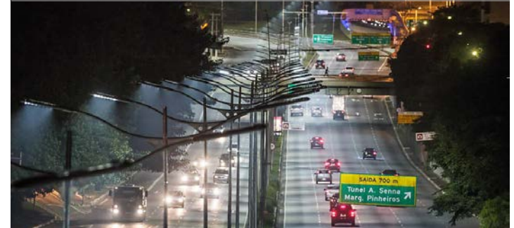
Avenida 23 de Maio 688 LED lamps installed
