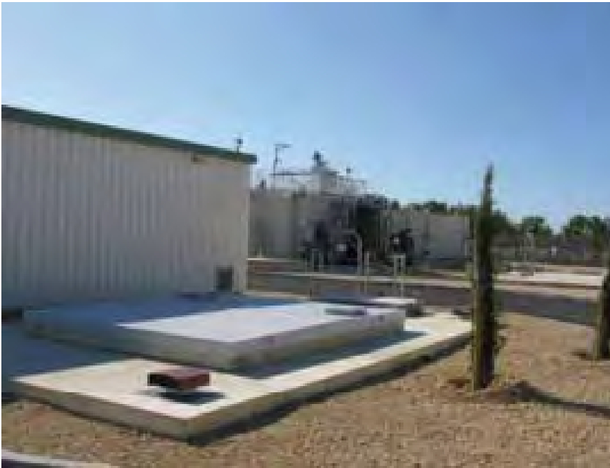
Centrale de vide
